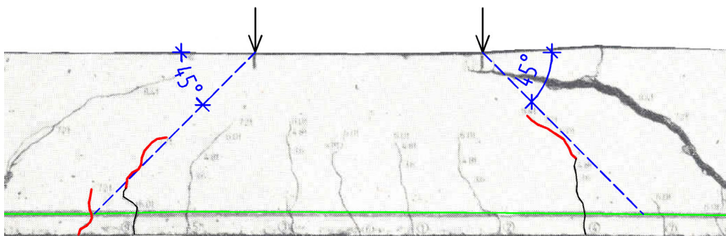
Bild A.4.18: Risse im Kräfteinleitungsbereich des Balkens D 3/2 mit radialen Abschnitten
